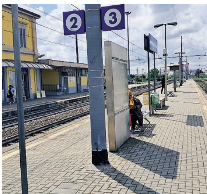
Le banchine senza pensiline alla stazione di Verdello-Dalmine
