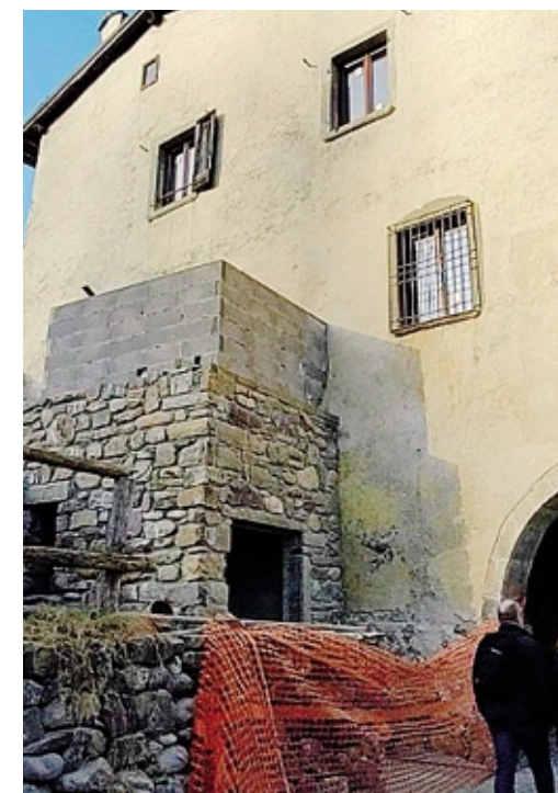
La struttura per l'ascensore addossata al Museo
