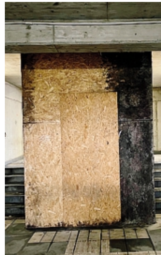
Il vano già predisposto
