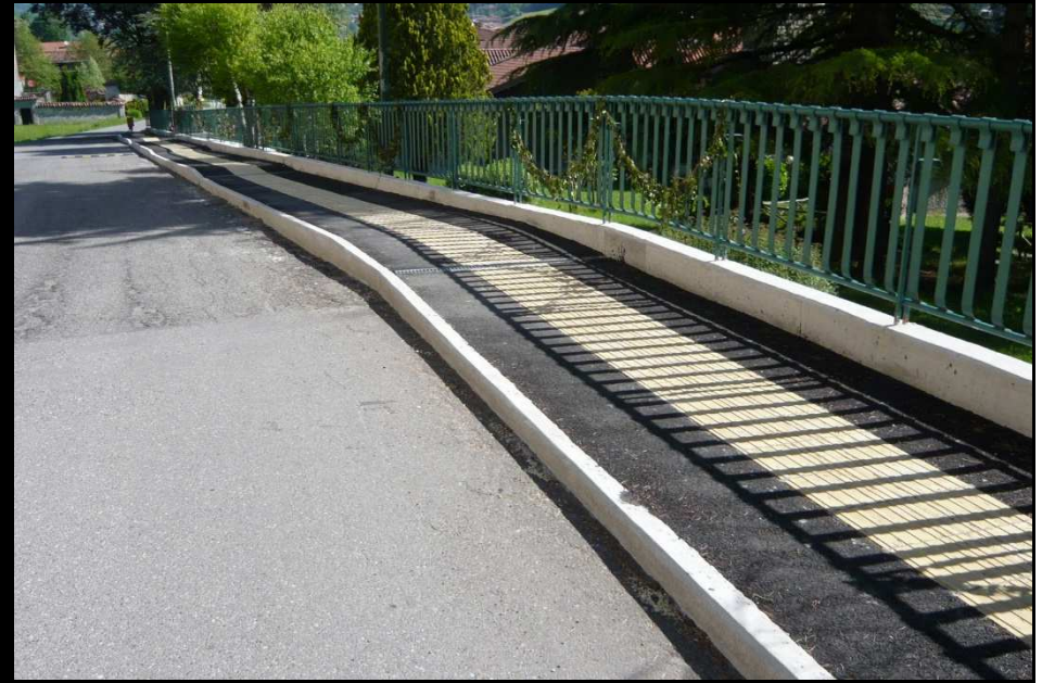
Marciapiede a Fuiipiano al Brembo
