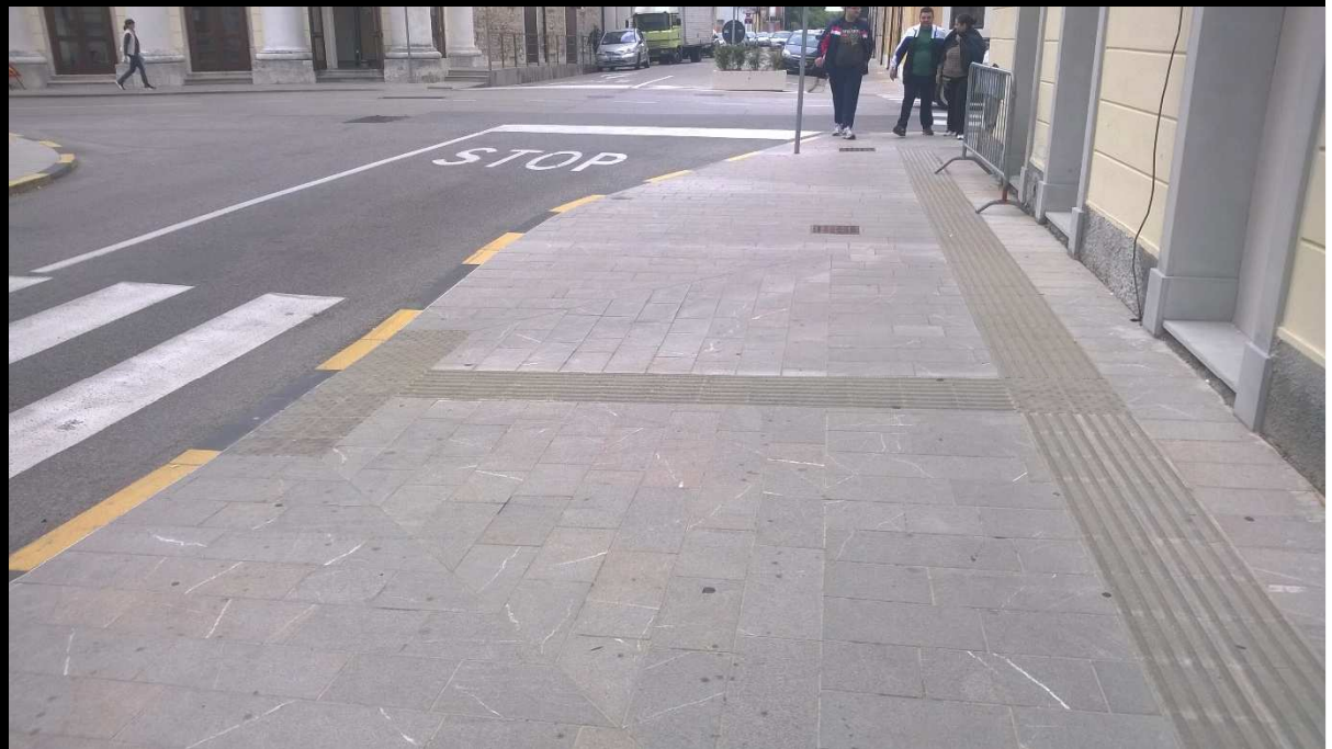
Marciapiede ed attraversamento stradale - Palmanova
