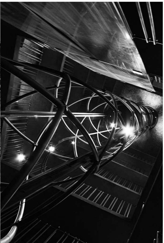
IMPIANTI SPECIALI Ascensore della Torre dell'Orologio, Praga (2000)
